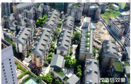
▲屋顶平改坡示例：武汉市江岸区惠西小区屋顶改造
