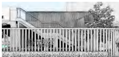
▲青山区青翠苑社区围墙改造
