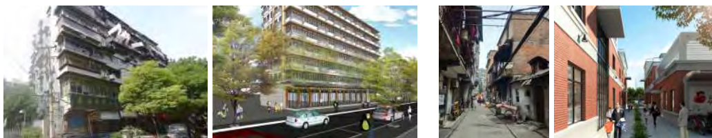
▲武胜西街4号建筑现状
